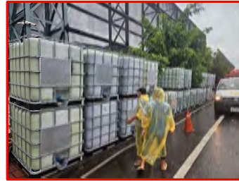
業者廢液抽除情形
