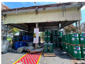
危險品室外儲存場I區 (丙烯酸類未波及)
