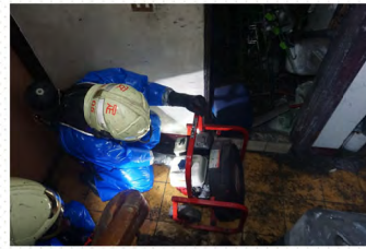
架置排風設備
