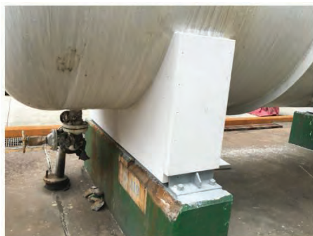
裙座防火板施作完成實例
