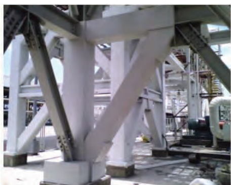
樑柱系統防火板施作完成實例
