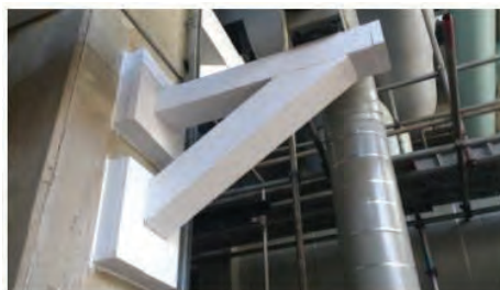
支撐系統防火板施作完成實例
