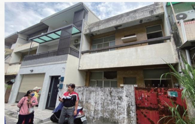
▲ 老舊房屋未整修
