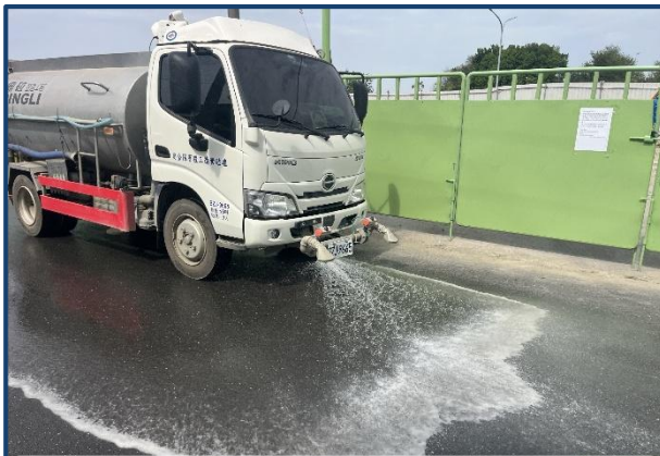
工區道路定時灑水
