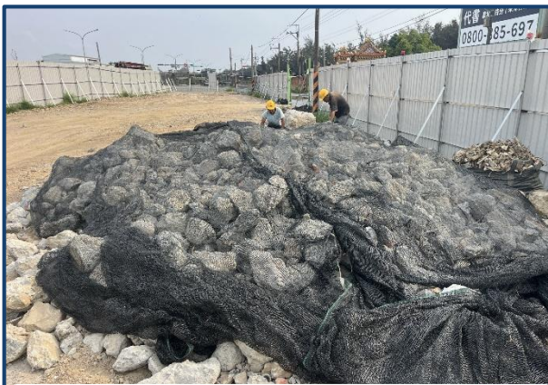
暫置土石方覆蓋防塵網
