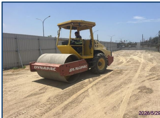
確認回填面碎石夯實
