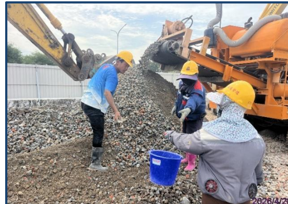
破碎後撿拾雜質後回填
